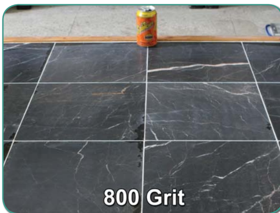
Рисунок 4-C: Состояние пола после обработки светло-желтыми алмазными пластинами (800 Grit).
