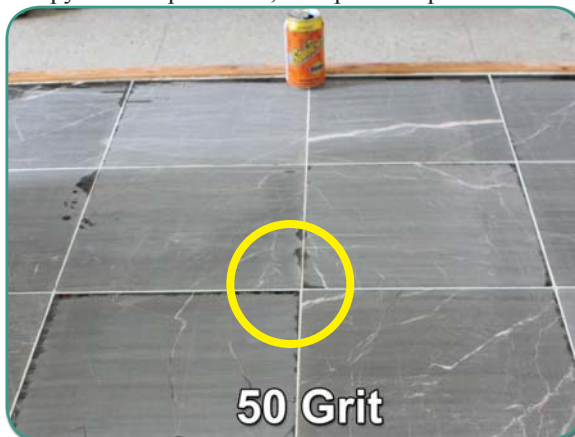
Рисунок 2-C: Пол после обработки пластинами 50 Grit. Обратите внимание, что неровность стала менее заметной.
