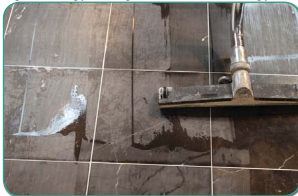
Рисунок 1-В: С помощью пылесоса для влажной уборки полностью удалите образовавшуюся суспензию.
