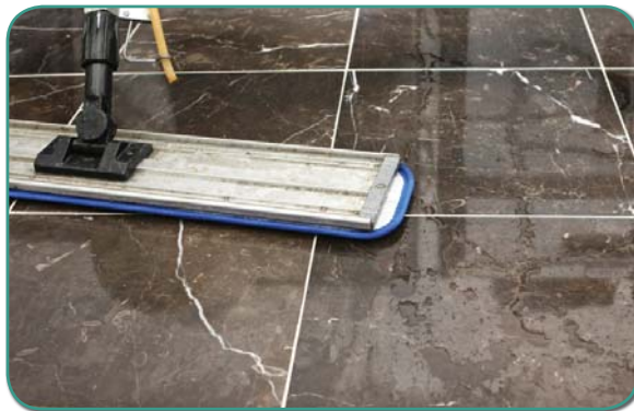
Рисунок 1-С: EZ-аппликатором с насадкой из микрофибры удалите частицы, оставшиеся после пылесоса.
