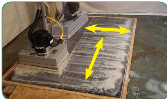
Рисунок 1-Д: При работе всегда двигайтесь только вперед или назад. Никогда не перемещайте машину в боковую сторону.
