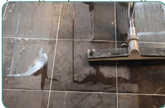
Рисунок 3-В: С помощью пылесоса для влажной уборки полностью удалите образовавшуюся суспензию.
