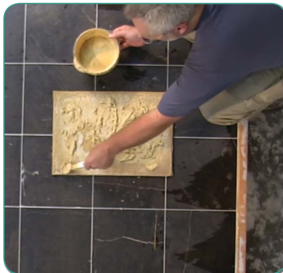
Рисунок 5-В: Необходимо добиться однородной массы, не содержащей комков, близкой по консистенции к молочному коктейлю.
