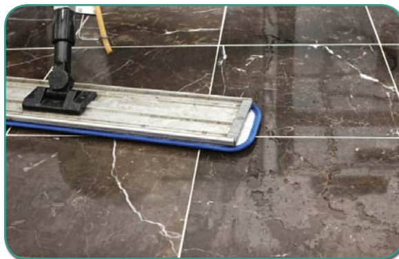
Рисунок 3-С: EZ-аппликатором с насадкой из микрофибры удалите частицы, оставшиеся после пылесоса.
