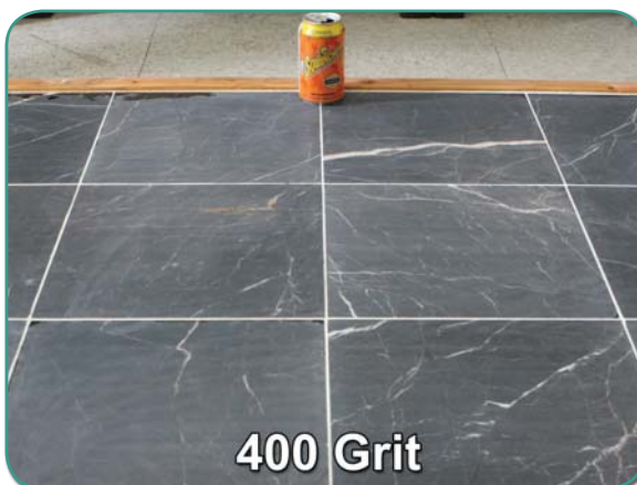
Рисунок 4-B: Состояние пола после обработки бордовыми алмазными пластинами (400 Grit).
